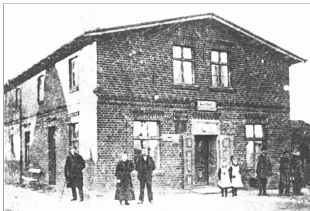
Ryc. 31. Przystawy, sklep kolonialny (Anonim 1987: 200)
