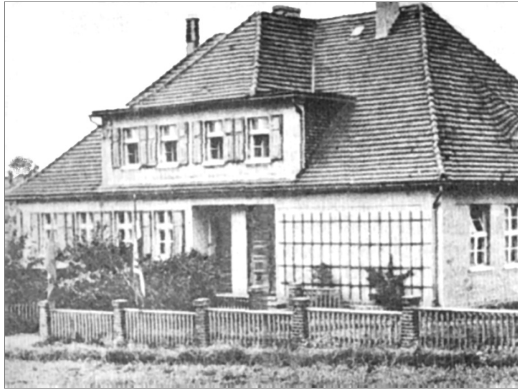
Ryc. 23. Pękanino, budynek szkoły (Schünemann 1989: 1069)
