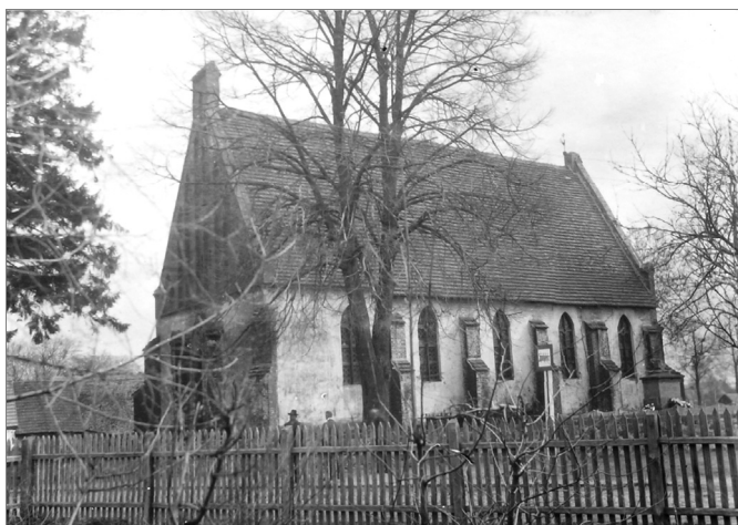
Ryc. 25. Malechowo, widok kościoła od południa (zbiory Muzeum Narodowego w Szczecinie, zdjęcie inwentaryzacyjne)
